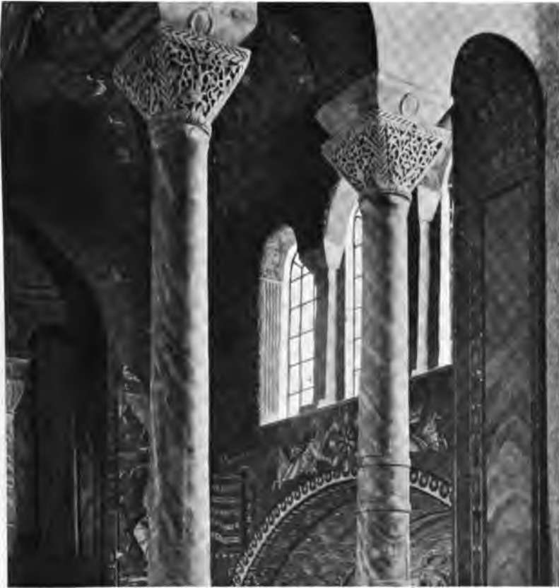
Fig. 35. — Chapiteau à décor de broderie enveloppant la campane et supportant un épais tailloir sous la retombée des arcs des tribunes à Saint-Vital de Ravenne.
